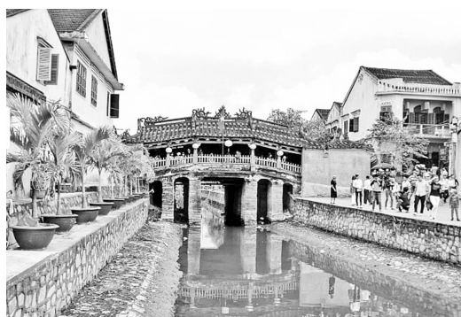
Hình 21. Cầu Chùa bắc qua sông Hoài. [5]
